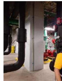
**Columna de concreto con presencia de manchas y tonalidad diferente a los muros**
