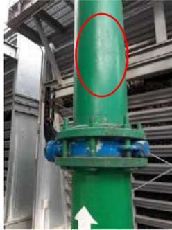
**Diferencia de color en tubería al exterior y desgaste en recubrimiento azul y verde**
