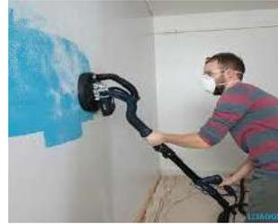
Lijado mecánico de muros con aspirado integrado
